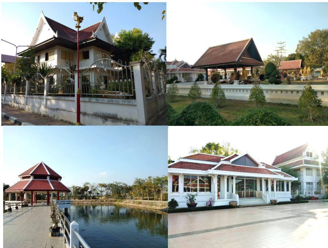
ภาพที่ ๔๓ อาคารและสิ่งก่อสร้างต่างๆภายในบริเวณวัด
